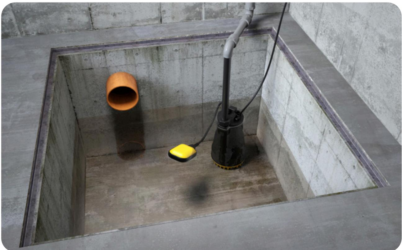
Abb.: Tauchpumpe ZM A mit Schwimmerschalter im Pumpensumpf
